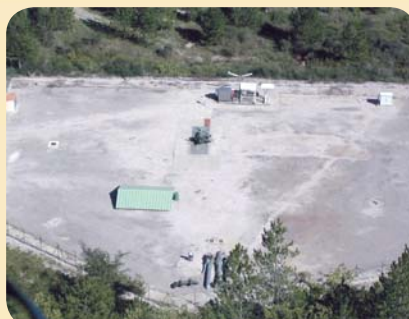
Isolation d'une tête de puits par rapport à la végétation environnante sur le site de Géométhane
