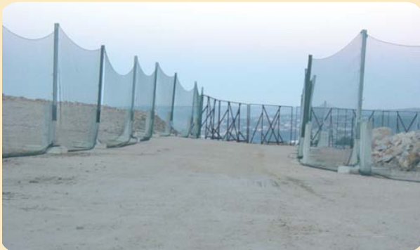
Procédure Grand Vent du site Veolia : mise en place de filets métalliques souples qui évitent l'envol de déchets vers le domaine forestier. Cet exemple est un cas particulier mais montre la mise en place de parade pour éviter la propagation d'incendie intra-site vers le domaine forestier.
