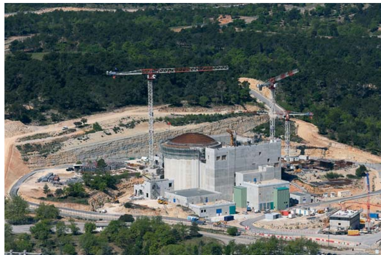
Vue du chantier du futur réacteur Jules Horowitz
